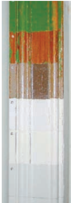
En konservatorundersøgelse afslørede ikke færre end seks farvelag på busets gerigter.
