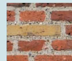
...og efter restaurering, hvor den oprindelige fuge er genskabt – med gullig mørtel af bakkesand og tilslag af sort strandgrus.
