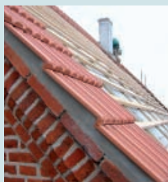
Efter restaureringen har havnemesterboligen igen fået tag af den originale falstagsten.
