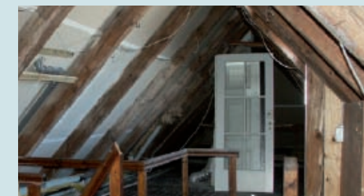
Det gamle undertag af gipsplader er fjernet, og i stedet er der lagt et nyt undertag af brædder og pap.
