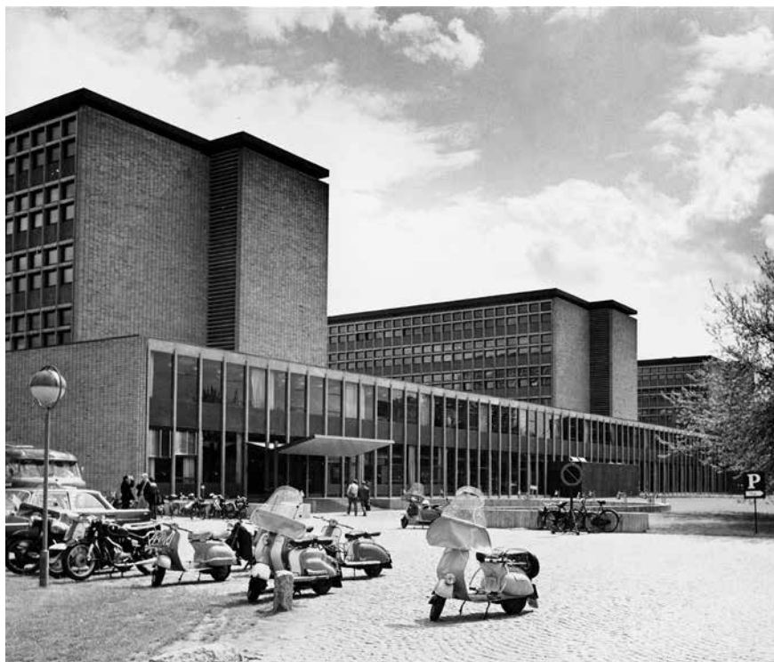
H.C. Ørsted Institutet [1957-64] i København. Bygningerne er de første offentlige bygninger i Danmark med klare brutalistiske træk.
