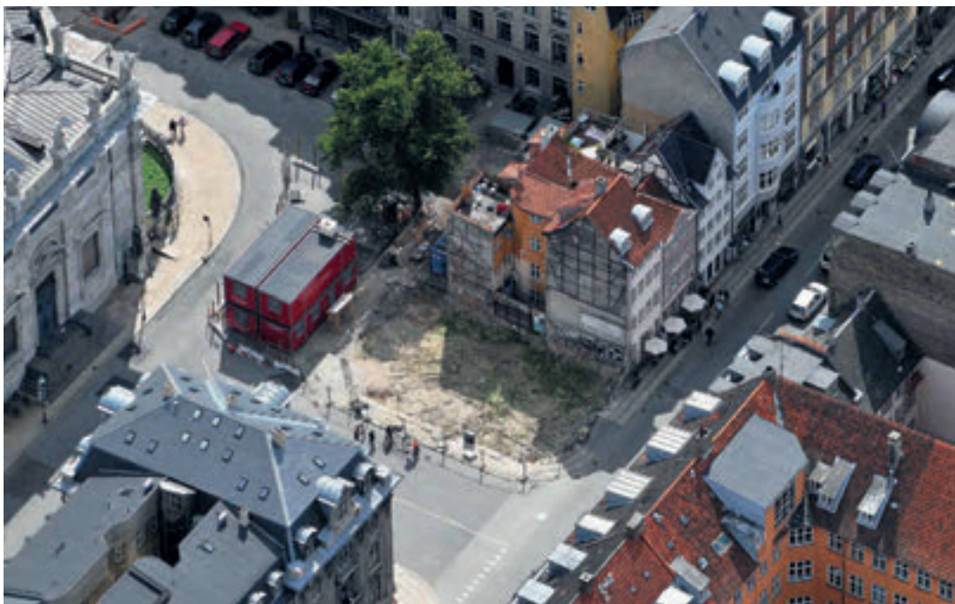
Tietgens grund inden byggestart.
