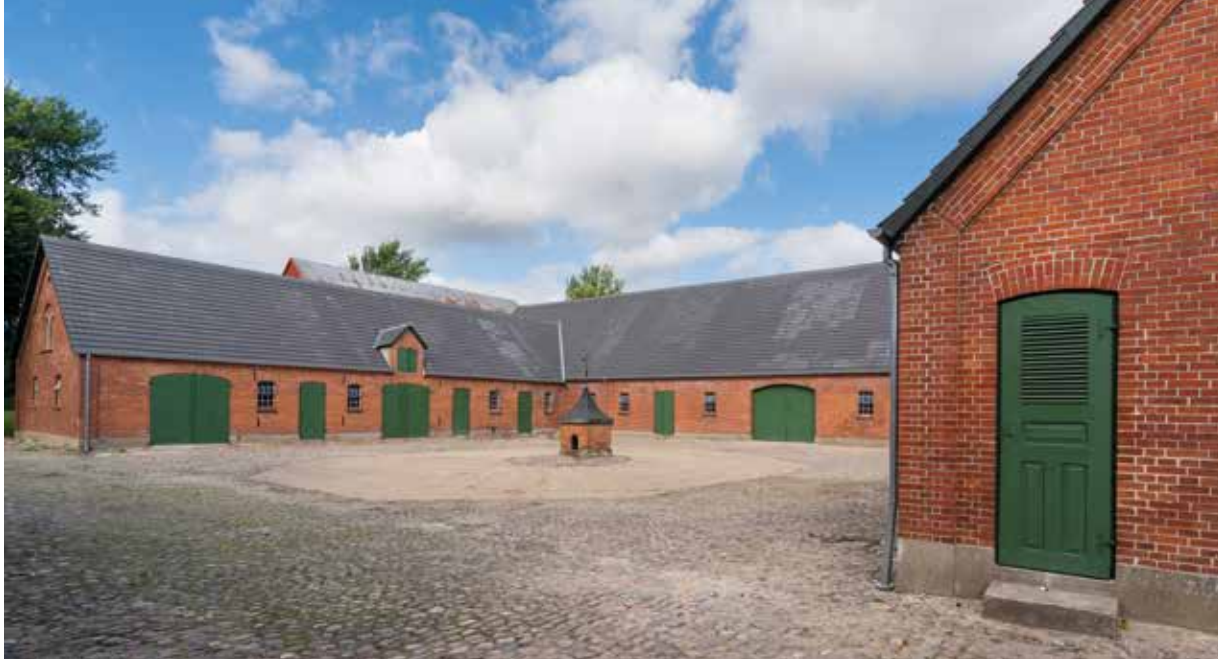
Fra vaskehus og bryggers havde gårdens ansatte adgang til de tre avlslænger, som var moderne og rationelt indrettet. Den lille kvist med luge ind til loftet gjorde det nemmere at bringe foder og korn ind og ud. En tilsvarende luge findes på den modsatte længe. Til højre ses døren til dasset.
