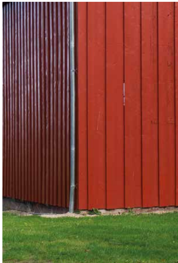
I den store lade fra 1927 er en meget stor del af træet i dag udskiftet. Mange af brædderne var så medtagne, at de nærmest kun blev holdt sammen af malingen.
