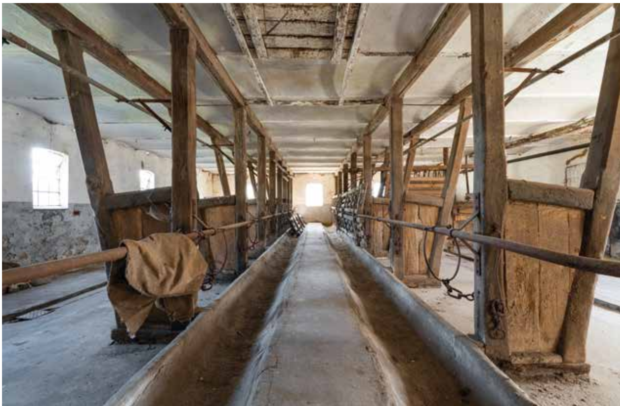
Den gamle kostald står uforandret som for 120 år siden. Lofterne blev dengang opbygget som moderne monierhvælv, dvs. hvælv af beton med jernarmering. Også gulvene blev lagt med cement i stedet for de ujævne marksten, som tidligere havde været brugt.
